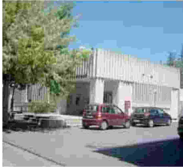
L'ufficio postale ubicato in via Firenze è al centro dell'attenzione per la presunte carenze igienico-sanitarie
