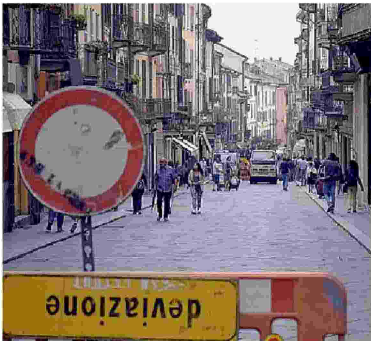
DEVIAZIONE Il cartello che vieta l'accesso ai mezzi a causa dei lavori sulla strada. Coinvolte le linee 1 e 6
