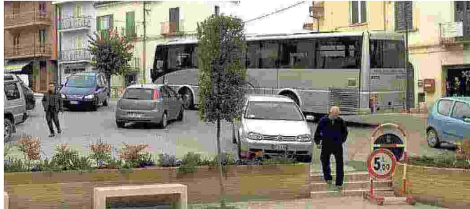
Disagi per le manovre dei bus dopo i lavori in piazza Brigata Maiella
