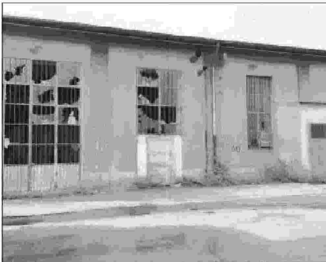
Il capannone che a breve sarà ristrutturato
